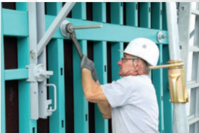
La dernière rangée d'écrous à 1,86 m de hauteur facilite le serrage à partir du sol.
