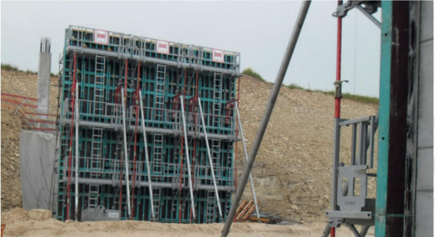
Ouvrages routiers : réalisation de pont cadre et culées.
