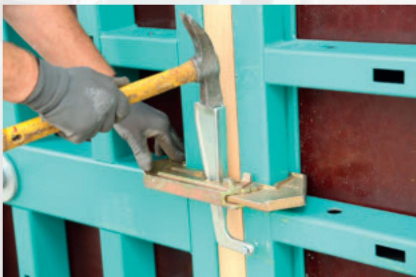
Assemblage d'éléments avec fourrure bois de 60 mm intercalée à l'aide de serrures PERFORM/FLEXEL.
